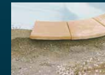
POSE DES MARGELLES
