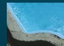
ASSISE BÉTON DES MARGELLES
