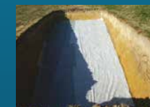
POSE DU GEOTEXTILE
